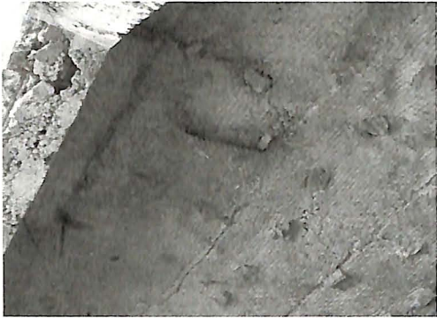
写真2 旧茂原航空基地の第五号掩体壕内部天井
