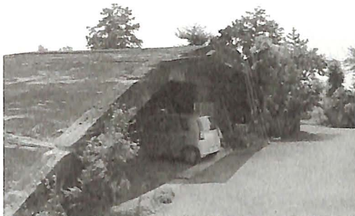
写真 6-1 外観（開口部側より）
