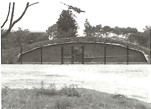
写真 9 - 1 大沢一号掩体壕
