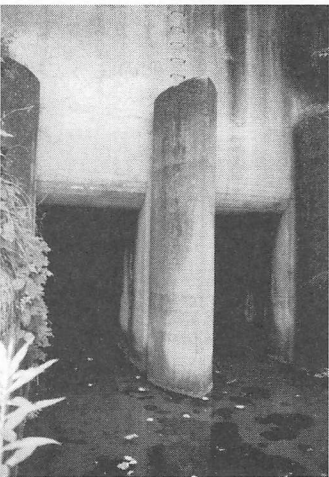
写真5 連絡隧道出口（第一・第二調整池間）
