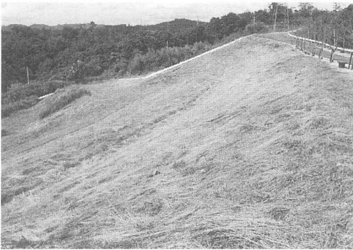
写真3 女子畑第一調整池第三号ダム跡
