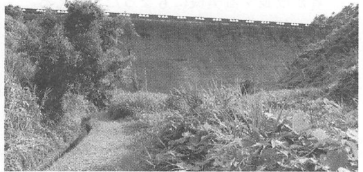
写真4 女子畑第二調整池ダム
